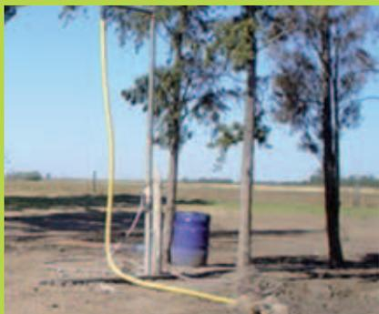
En las fotografías de la página anterior se muestran dos tipos de estaciones de carga de agua: ambas usan el efecto cigüeña, dado que toman de un tanque cisterna con calidad de agua conocida y de media profundidad de manera de no levantar sedimentos
