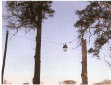
Una de las luminarias esta colgando muy abajo debido a que uno de los postes que la sostiene esta inclinado porque el piso se esta venciendo como consecuencia de la zanja que hicieron para instalar el gas natural, debido a esto en mas de una oportunidad pasaron camiones con semirremolques térmicos, que rompieron la luminaria o quemaron la lámpara. Cabe destacar
