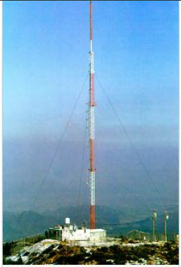
Un mástil de radio arriostrado. Las líneas de tensión son apenas visibles.
