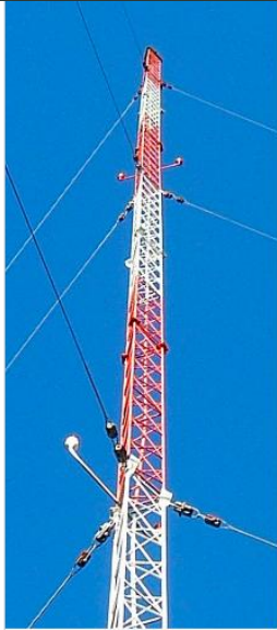
Mástil de radio de 200 pies (61 m) de una estación de radio AM en Mount Vernon, Washington , EE. UU., Soportado por tres juegos de líneas
