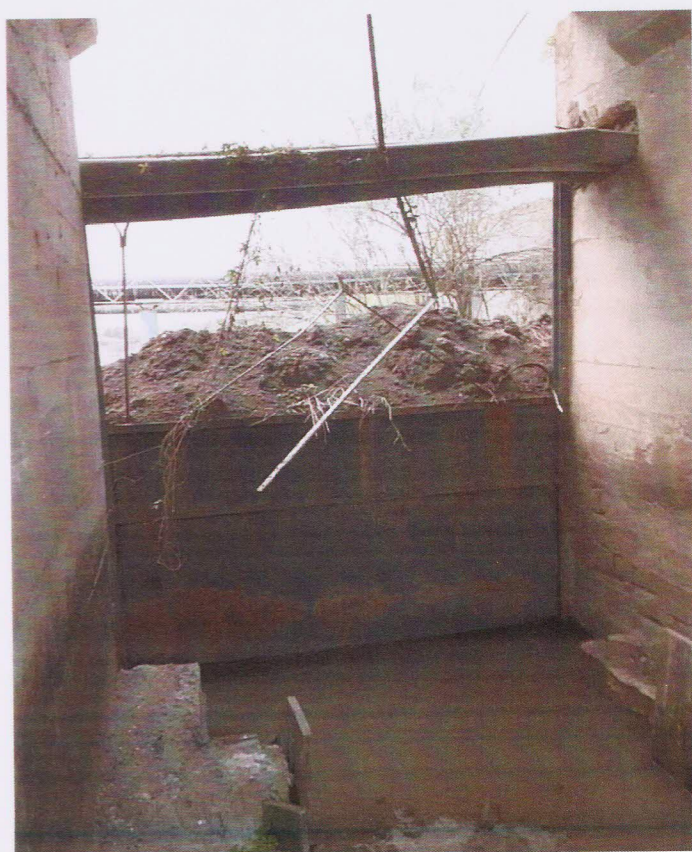
COMPUERTA DETERIORADA A CAMBIAR
